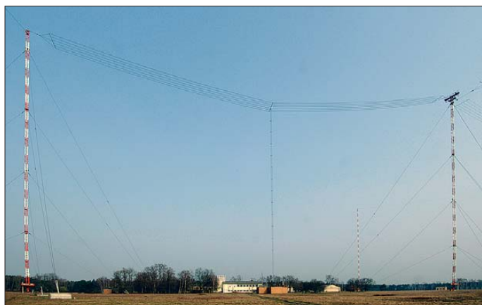
Bild 1: Blick auf die DCF77-Sendean- tenne mit Dachkapazität
